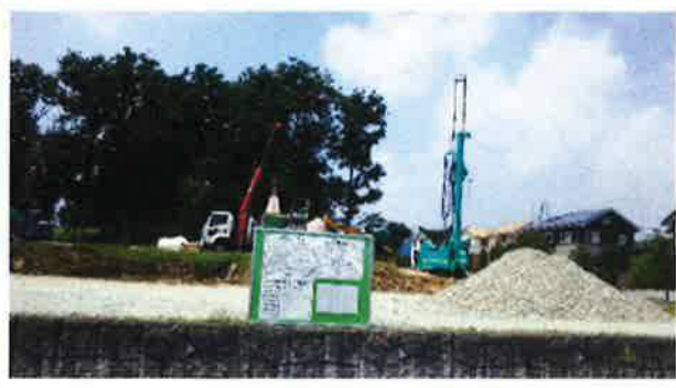
平成30年6月14日 着工
