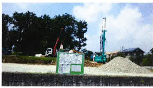
平成30年6月14日 着工
