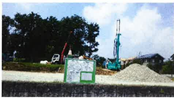
平成30年6月14日 着工
